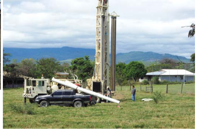
Perforando el nuevo pozo
