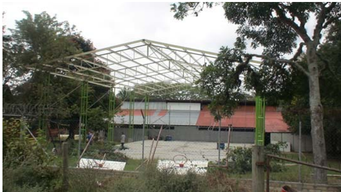
El nuevo techo para la cancha
