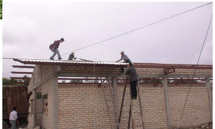
Costruyendo el arteson del centro comunal con los aprendices de soldadura
